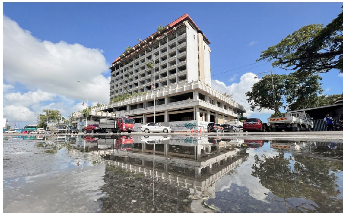
BANGUNAN terbiar yang dahulunya Hotel Labuan bakal dirobohkan untuk pembangunan semula.
