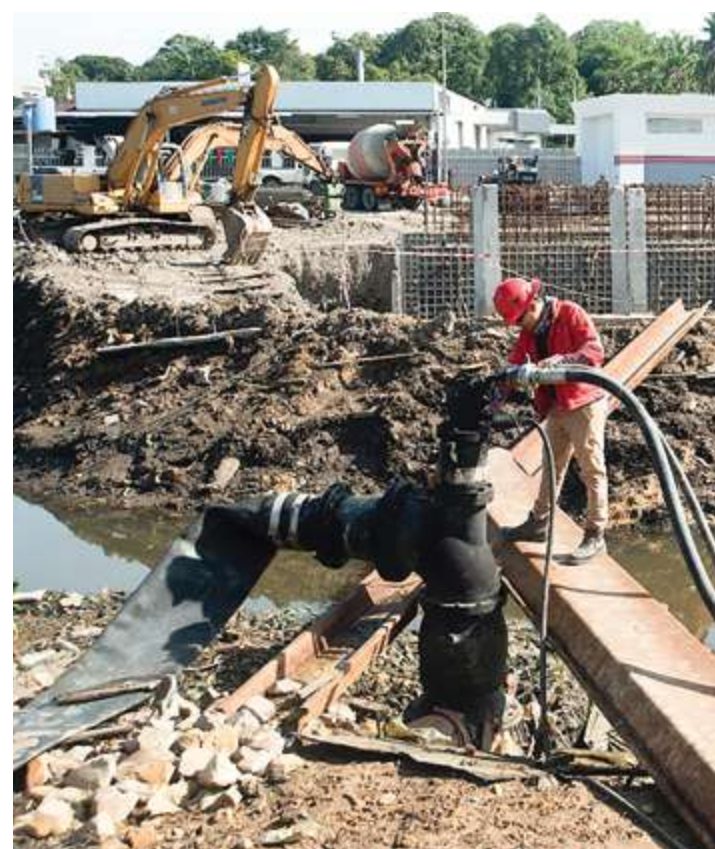
PELAKSANAAN Projek Outfall Spiral Pipe adalah langkah untuk mengatasi banjir.
