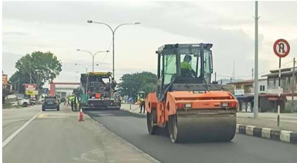
KERJA-KERJA penurapan jalan yang giat dilaksanakan di seluruh negara jelas membuktikan keprihatinan kerajaan untuk meningkatkan kualiti rangkaian jalan raya.
