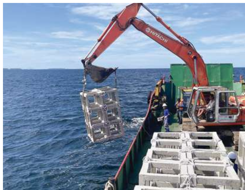
KERJA-KERJA melabuhkan unjam marinovasi yang dijalankan di Perairan Pohon Batu.
