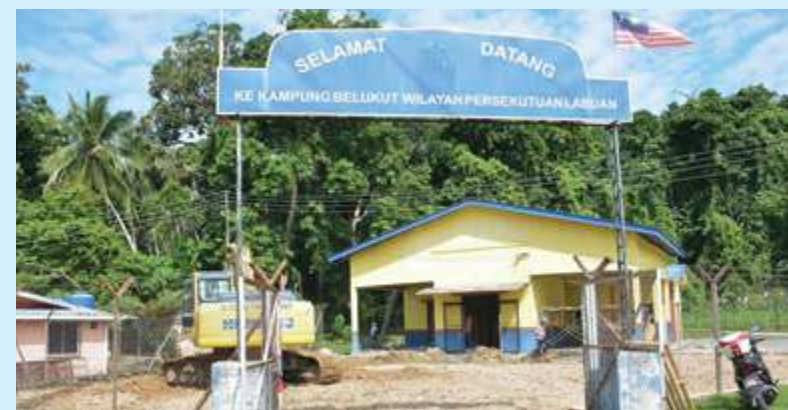
KERJA menaik taraf balai raya dan dewan terbuka sedang giat dilaksanakan.
