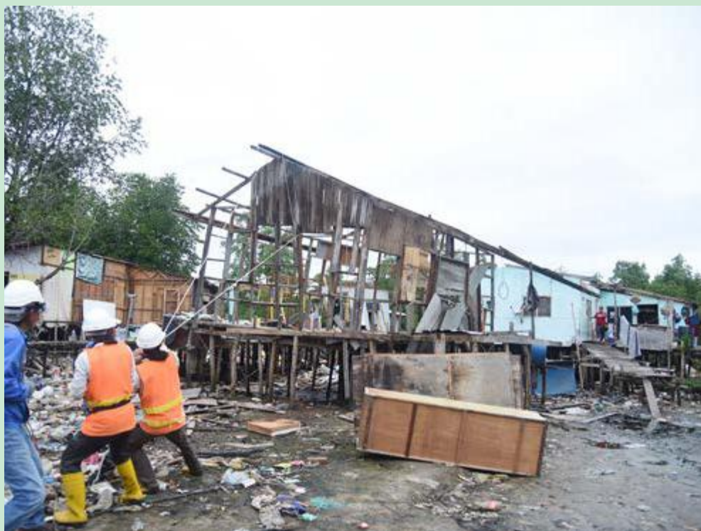
KERJA-KERJA perobohan rumah di penempatan haram tanah MUIS baru-baru ini.
