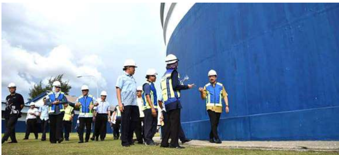
ZUKI (kanan) melawat Stesen Janakuasa Elektrik SESB di Patau-Patau pada lawatan kerja ke Labuan, baru-baru ini.
